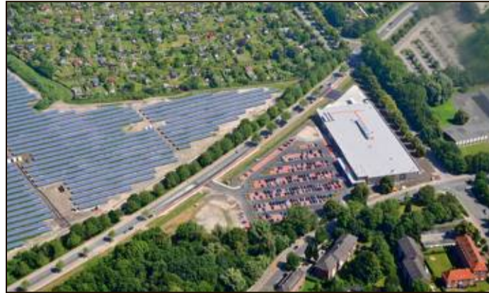
Die Volksbank hat den Solarpark an der Friedenstraße erworben und ist jetzt Stromerzeuger.
